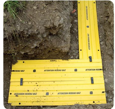
Assemblage longitudinal et transversal
